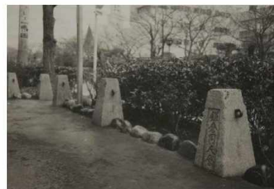
写真2-177 鎌倉同人会による 松並木防護柵の石柱跡 (昭和55年(1980年))
