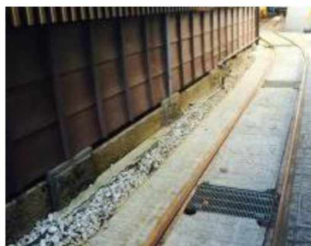
写真2-171 トロッコ用レール
