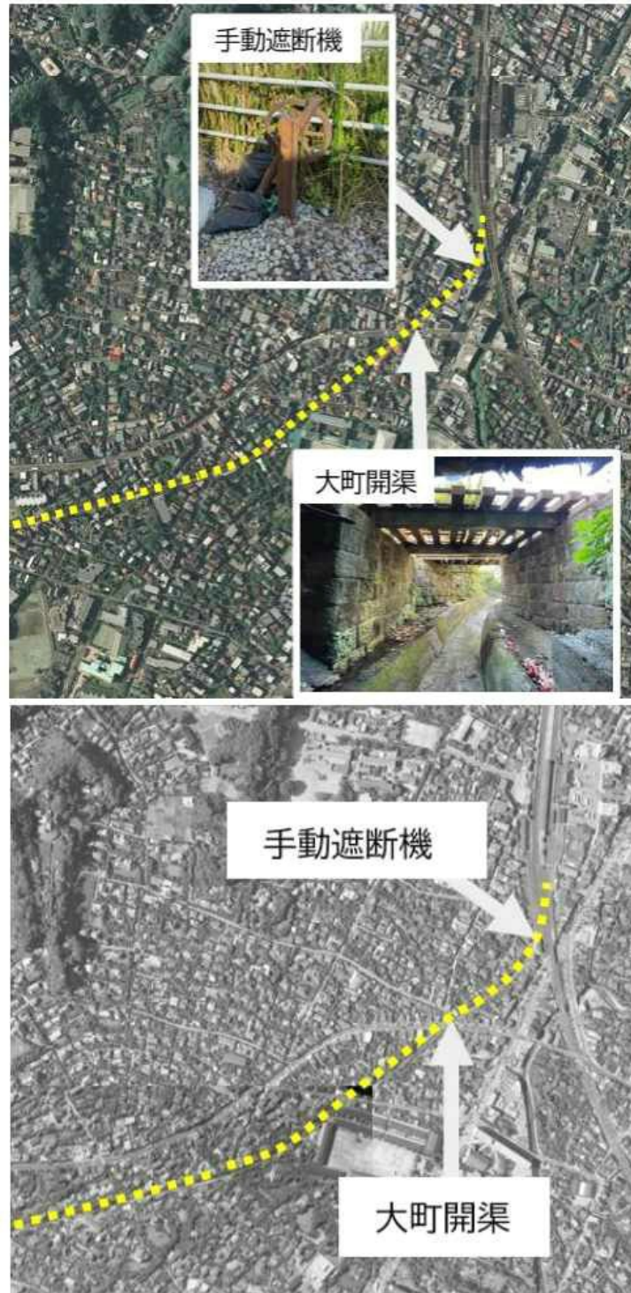
写真2-197 鎌倉駅・長谷駅周辺の鉄道関係構造物の航空写真と江ノ電軌道(点線) 現在(上)と昭和38年(1963年)(下)
