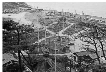
写真2-192 行合川の橋梁 (昭和42年(1967年))
