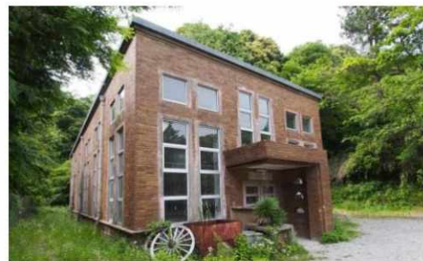
写真2-236 旧神奈川県営湘南水道 鎌倉加圧ポンプ所
