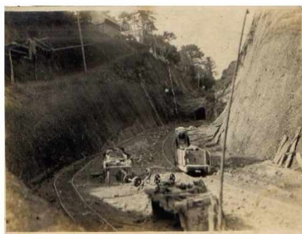
写真2-265 昭和の工事の写真 (昭和48年(1973年))
