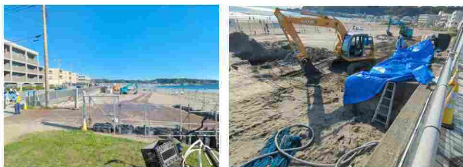
写真6-16 由比ヶ浜海岸における排水管路等の整備の様子
