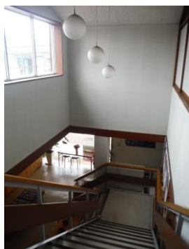
現況 階段室(耐震改修前)
