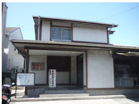
現況 外観(耐震改修前)
