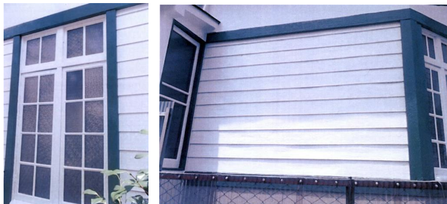
鎌倉聖ミカエル教会聖堂 外壁修繕後
