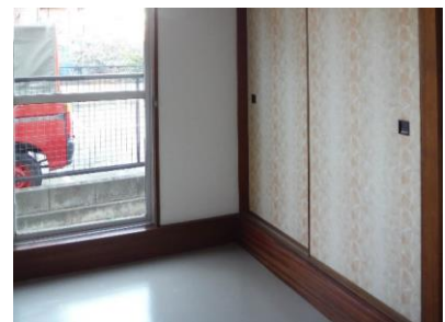
改修後(1階和室の洋室化: 段差解消)
