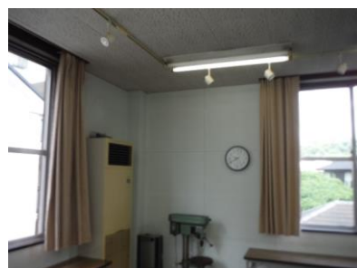
耐震改修前(2階会議室)
