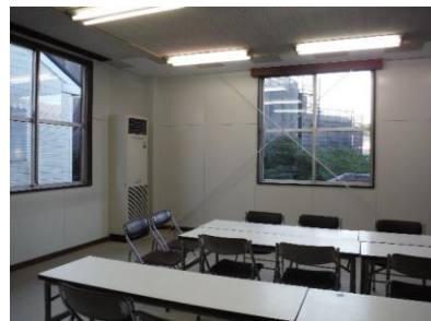
耐震改修後(2階会議室)
