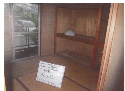
改修前(1階和室)
