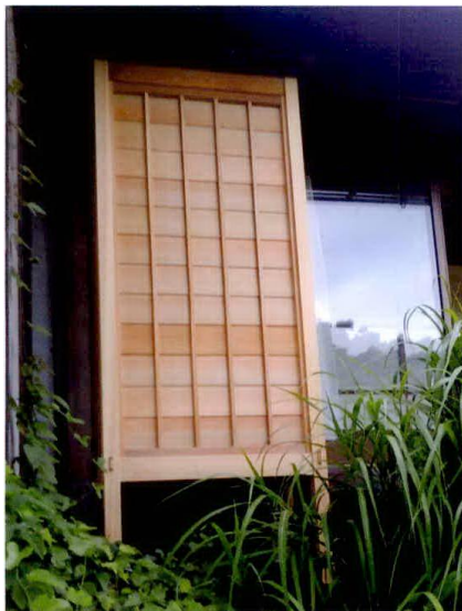
笹野邸 雨戸戸袋修繕後
