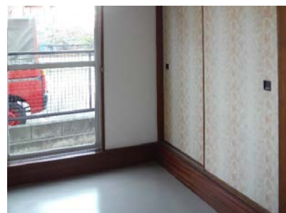
改修後(1階和室の洋室化：段差解消)
