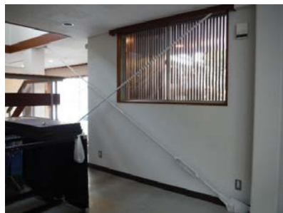
耐震改修後(1階展示室)
