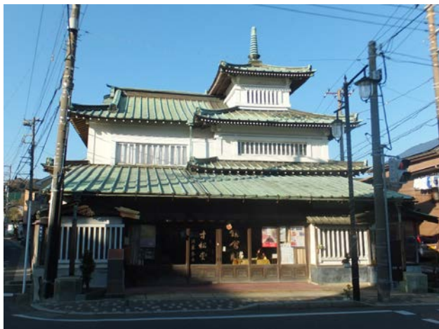
寸松堂 修繕後
