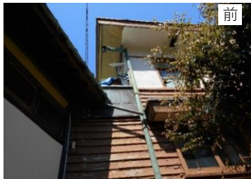
石川邸(旧里見弾邸) 軒裏等修繕
