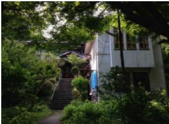
鎌倉風致保存会が取得し事務所として活用している 坂井家住宅洋館
