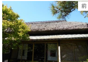
野尻邸(旧大佛次郎茶亭) 屋根補修
