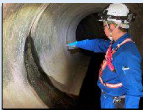
<参考>調査イメージ：潜行目視調査、ドローンによるテレビカメラ調査
