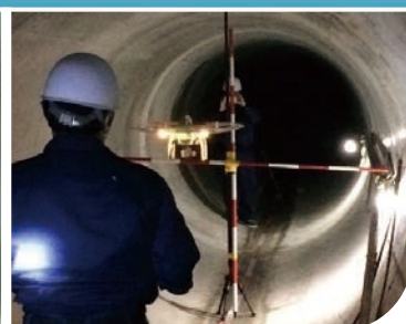
ドローンによる下水道管の調査
