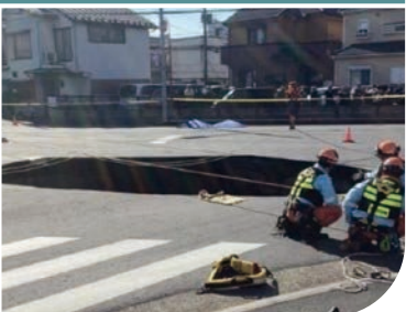
八潮市の道路陥没事故 (埼玉県下水道局 HP より引用)
