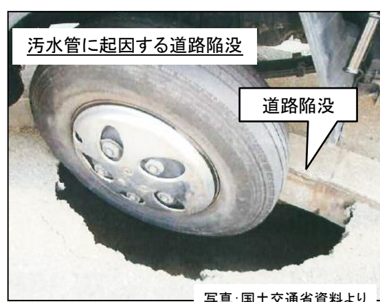
写真 污水管渠の破損状況
