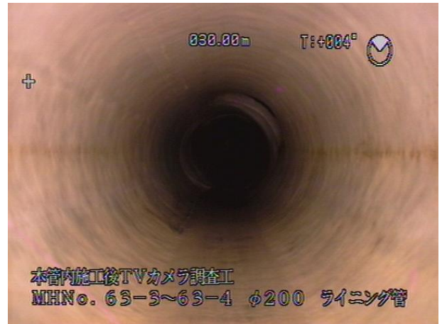
施工後の管の状態
