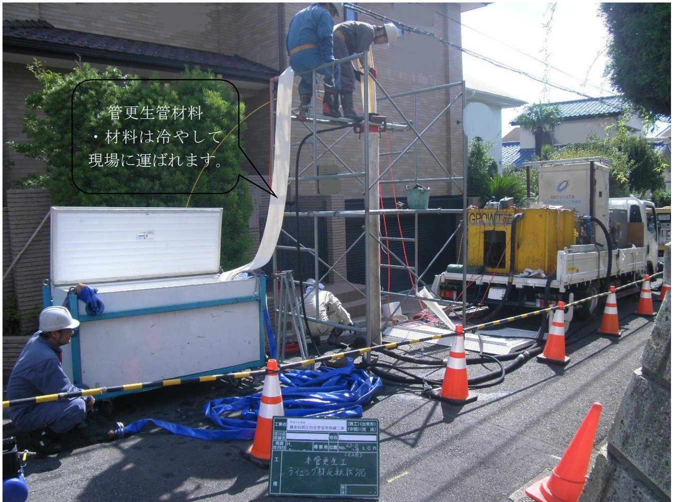
更生材料をマンホールから既設管に挿入している状況
