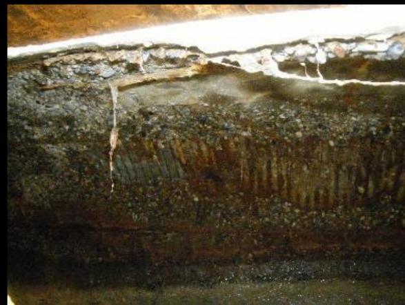
圧送管吐出し部付近の管の劣化状況(H22年七里ガ浜圧送管)
