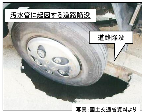
写真 污水管きよの破損状況
