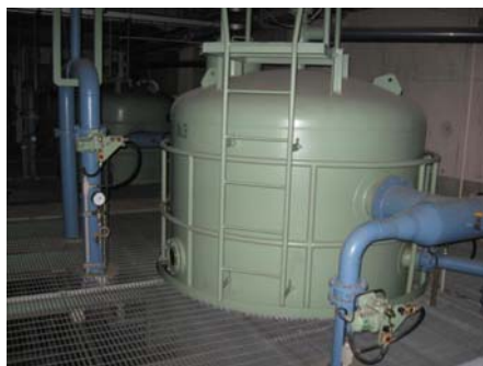
七里ガ浜浄化センター砂ろ過施設
