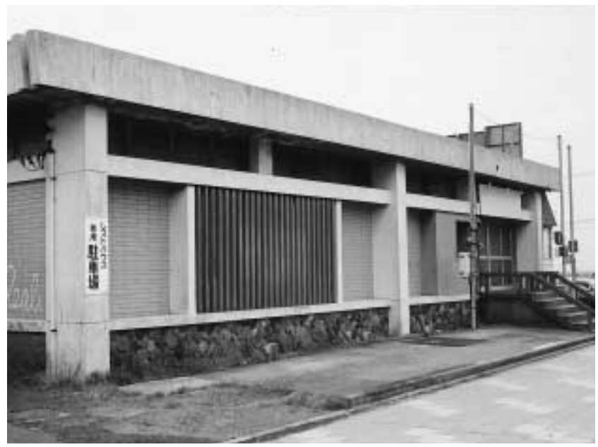
現在閉鎖されている滑川レストハウス
