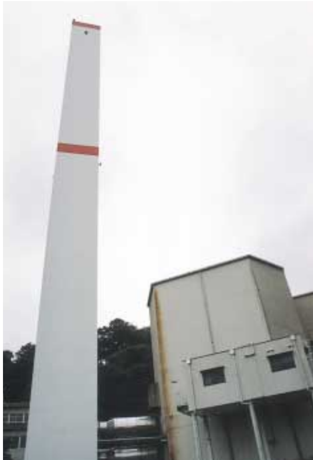
削減対策工事が行われる名越クリーンセンター
