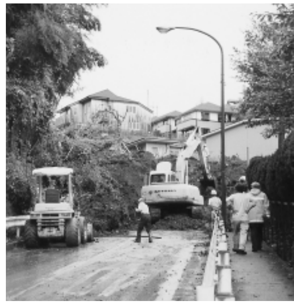
がけ崩れで全面通行止めとなった玉縄栄光坂
