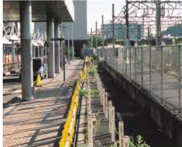
拡充される大船駅東口交通広場(右が線路、左が自転車レーン)
