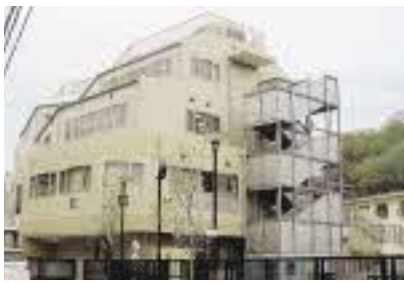
深沢保育園が入っている深沢こどもセンター
