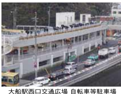
大船駅西口交通広場 自転車等駐車場
