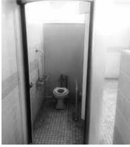
改修後のトイレ
