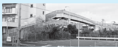
小袋谷歩道橋
