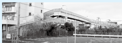
小袋谷歩道橋
