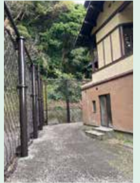
文学館西面の防護柵
