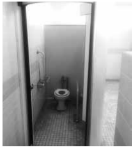
改修後のトイレ
