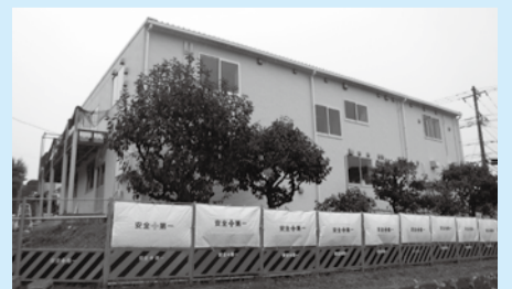
建設中の仮設園舎
