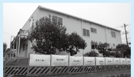
建設中の仮設園舎
