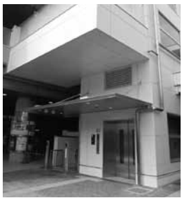
新設されたエレベーター
