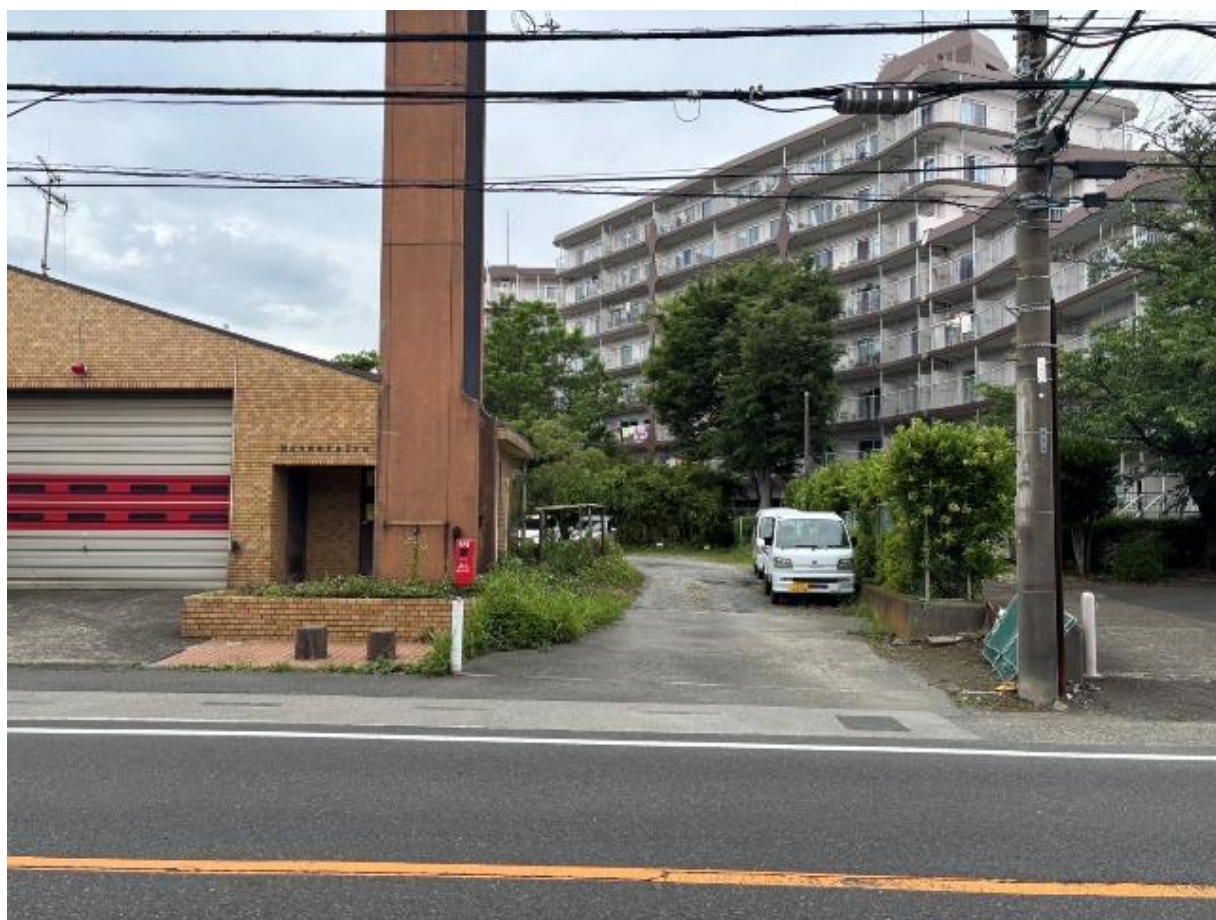
現況写真（令和7年（2025年）5月26日撮影）
