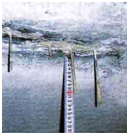
市内の建物に見られたつらら
