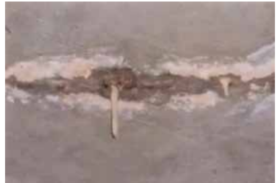
コンクリートのつらら (市内小学校)
