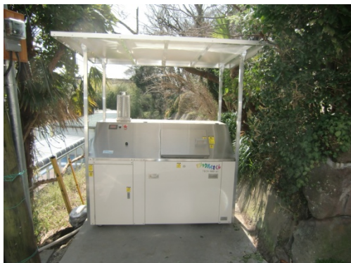
写真 6-1 西御門自治会の大型生ごみ処理機
