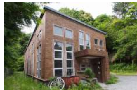
活用が予定される旧鎌倉加圧ポンプ所
