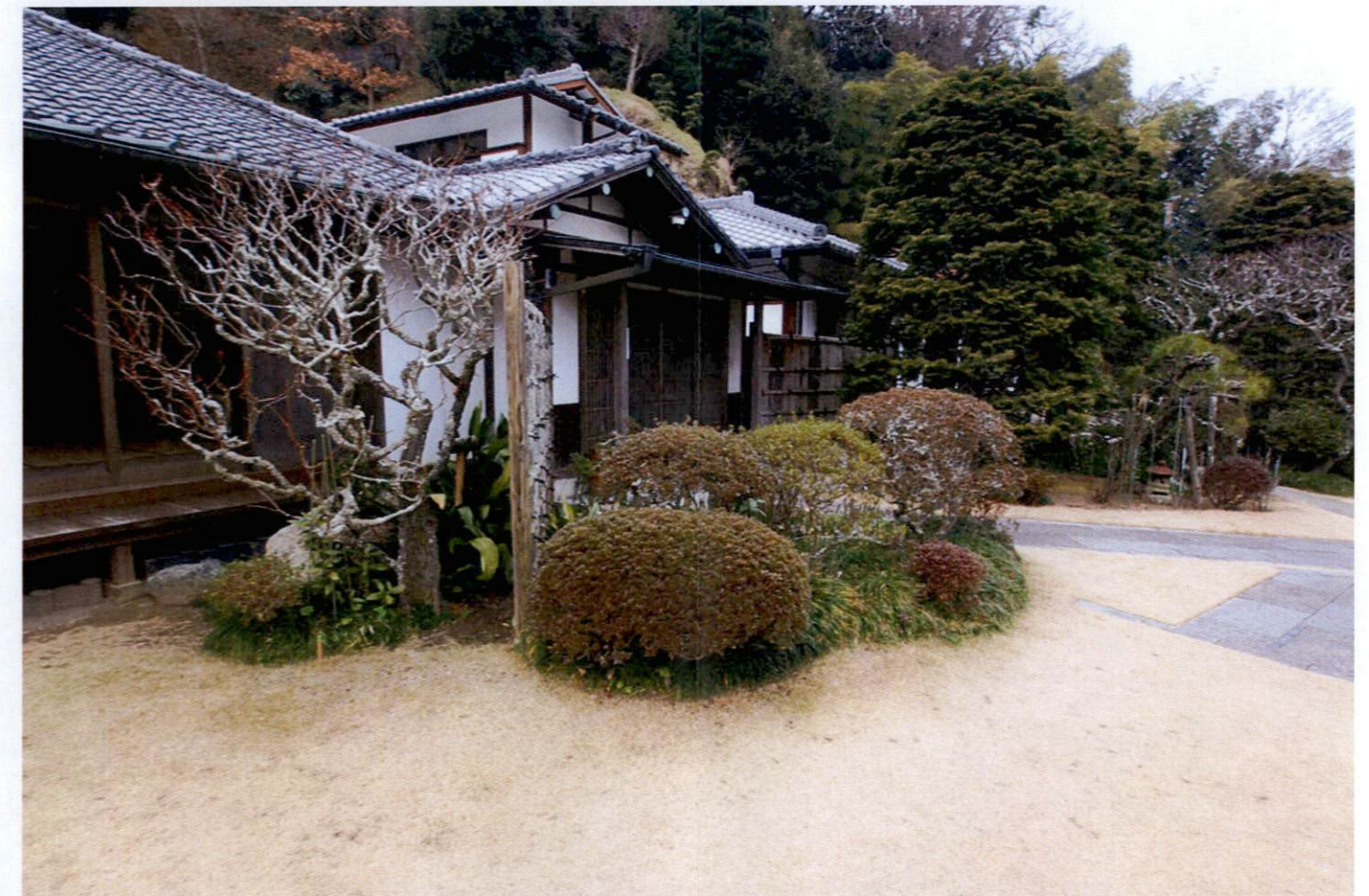
禅居院既存客殿 玄関周辺
