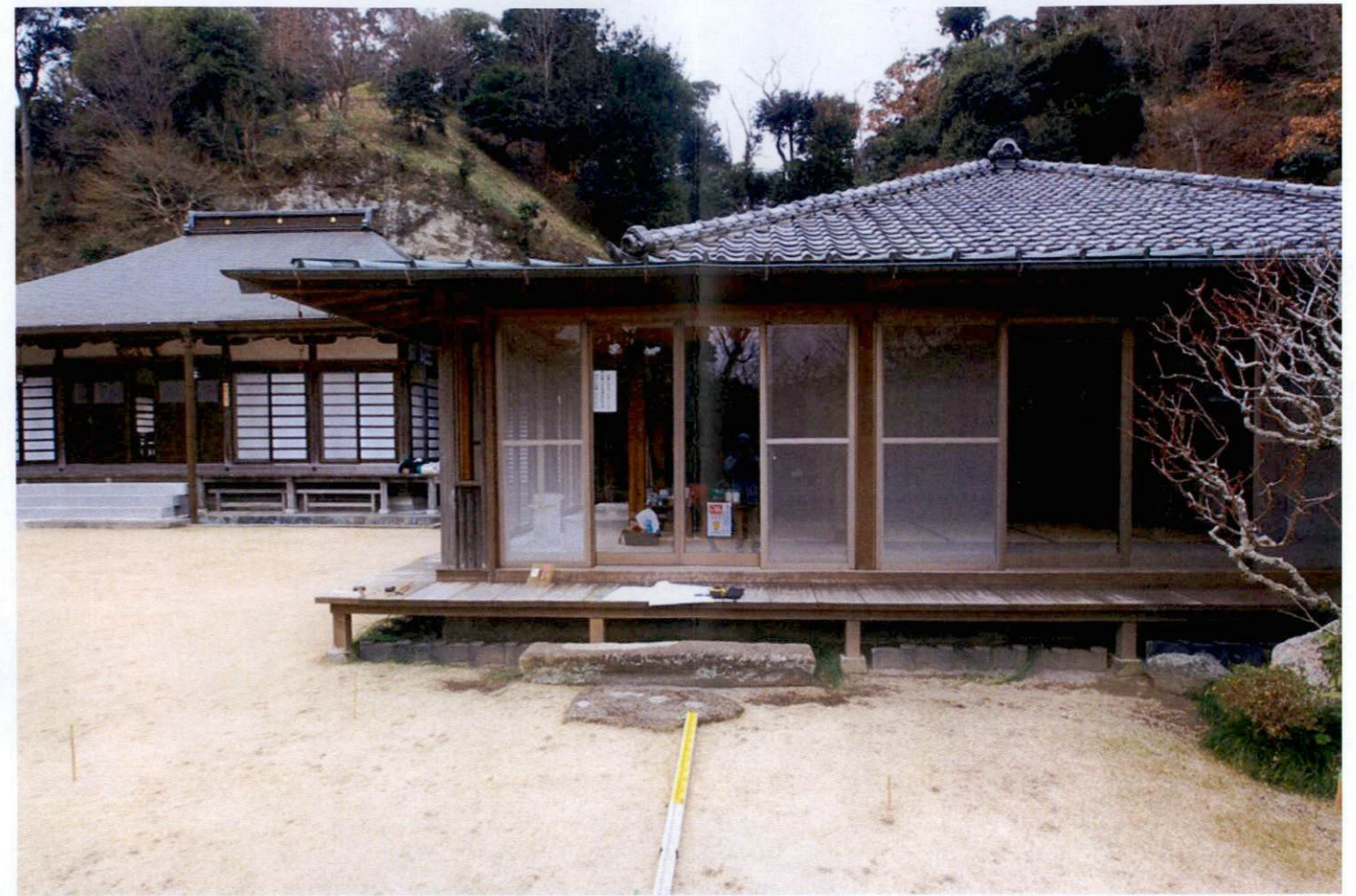
禅居院既存客殿 ※写真右側建物
