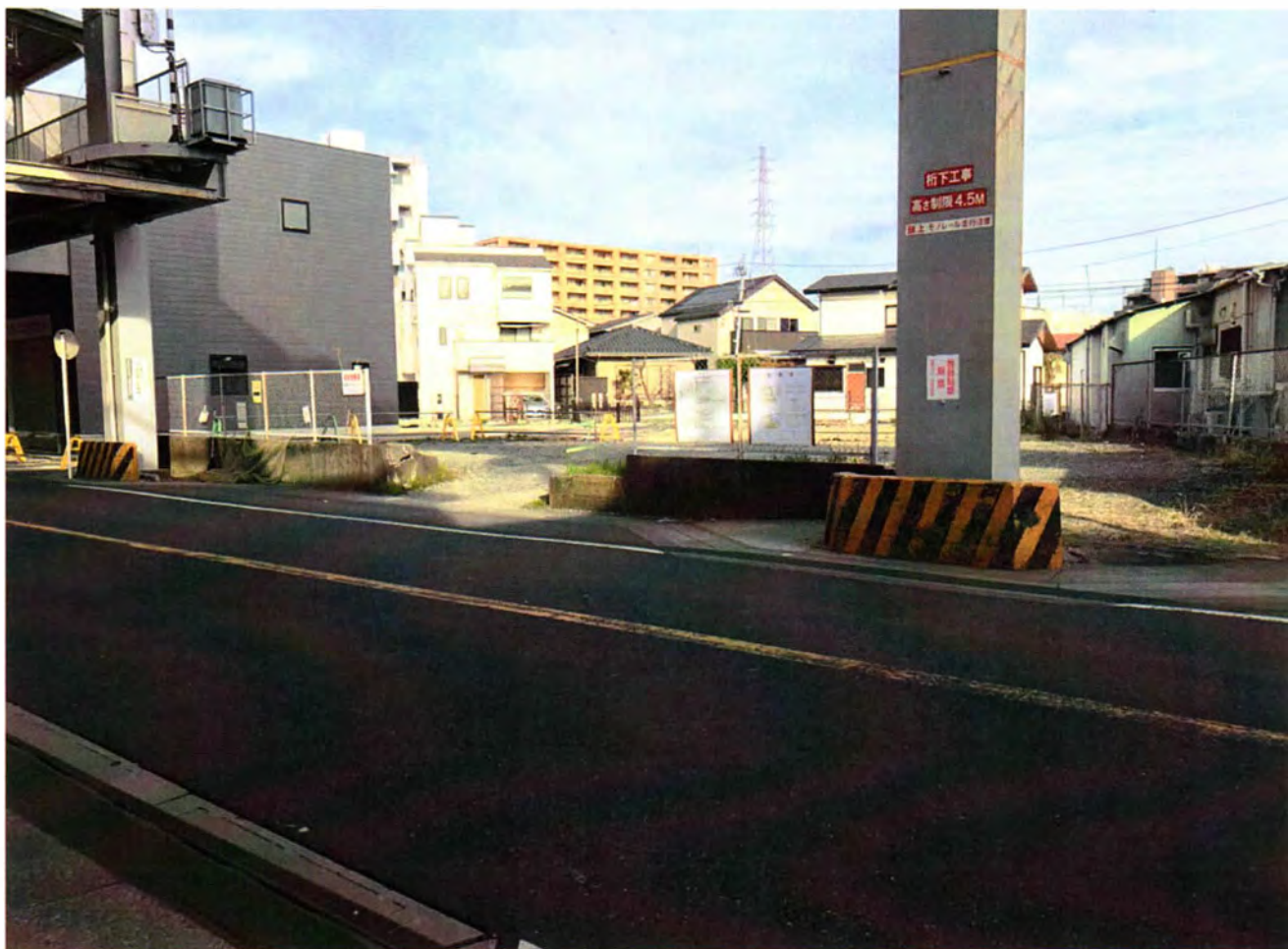
現況カラー写真：(仮称)鎌倉富士見町駅前店 新築工事
