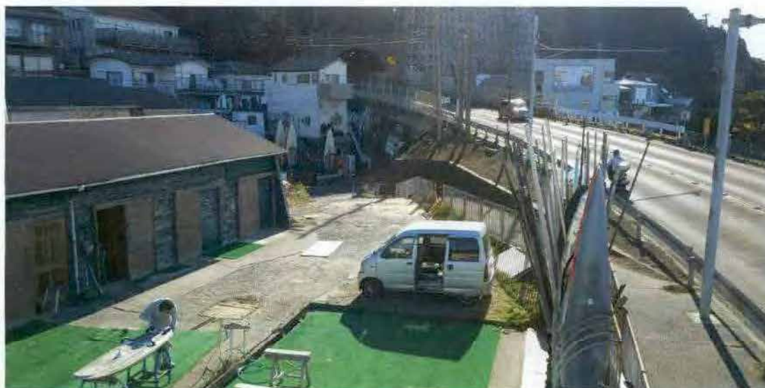
⑤国道 134 号線側（北側から南を見る）
