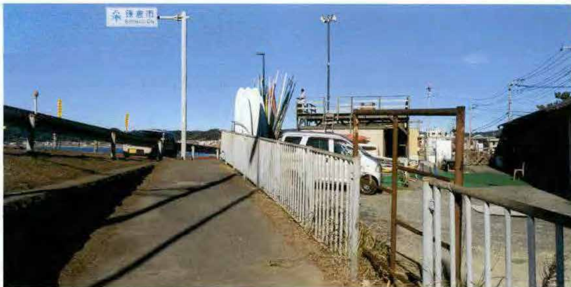
④国道 134 号線側（南側から北を見る）
