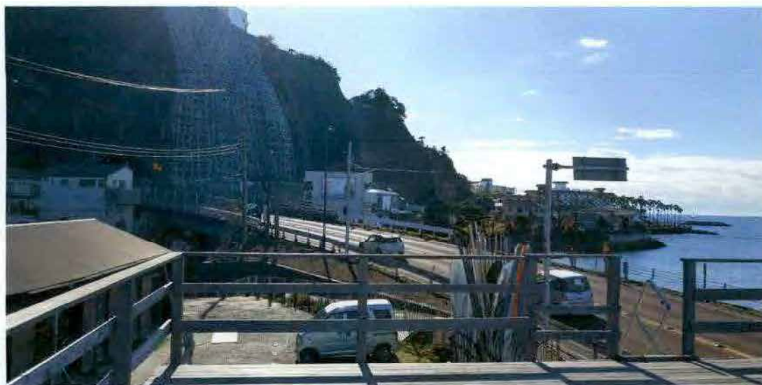
⑥国道 134 号線側（北側から南を見る）
