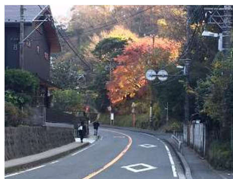
写真6-6 県道 21 号(山ノ内)
