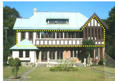
ハーフティンバースタイルとは柱、梁など骨組みをそのまま外部に現し、その間の壁を石材、土壁などを充填したもので、当時は最先端のデザインでした！
