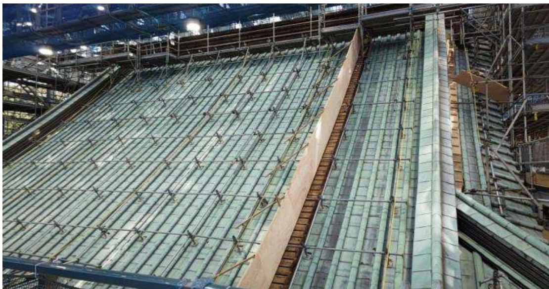
屋根工事等を実施(光明寺本堂)
