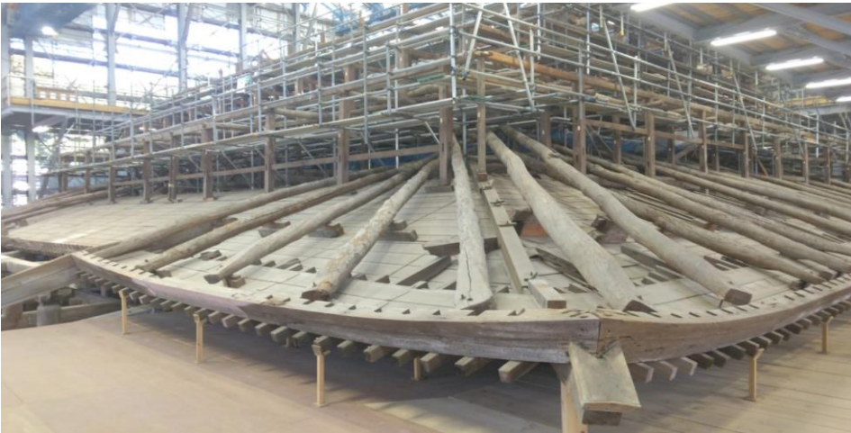
屋根工事等を実施(光明寺本堂)
