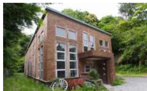
写真 旧神奈川県営湘南 水道鎌倉加圧ポンプ所
