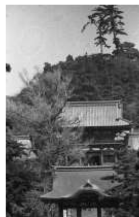
写真2-1 鶴岡八幡宮 (昭和36年(1961年))
