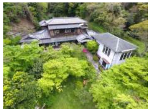
写真 坂井家住宅
