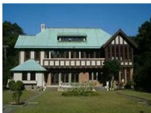
旧華頂宮邸の屋根・庭園の整備
