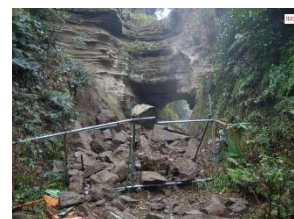
史跡大町釈迦堂口整備（整備前）
