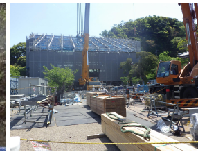
光明寺本堂の整備（施工中）
