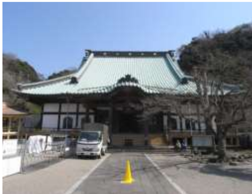
一部解体工事等を実施(光明寺本堂)
