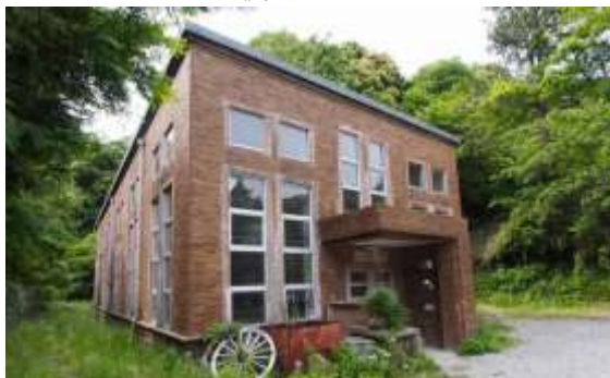
旧鎌倉加圧ポンプ所
