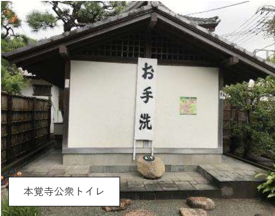
◆本覚寺公衆トイレ改修工事(平成30年度実施)
