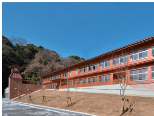
鎌倉市立第二中学校改築工事
