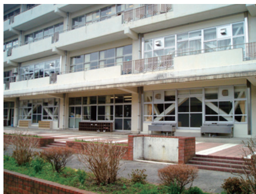
鎌倉市立関谷小学校の耐震改修工事
