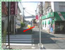
歩道の段差解消
