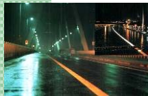
高輝度路面標示 (高視認性区画線)
