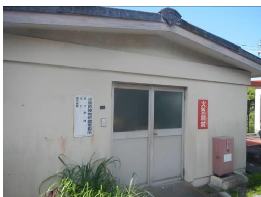
写真 4.1.3 鎌倉市深沢クリーンセンター 危険物屋内貯蔵所
