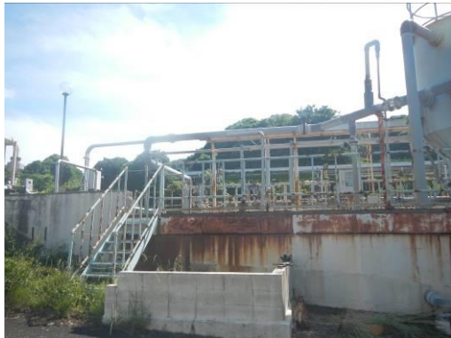
写真 3.1.3 鎌倉市深沢クリーンセンターし尿処理施設 (平成 11 年に廃止)
