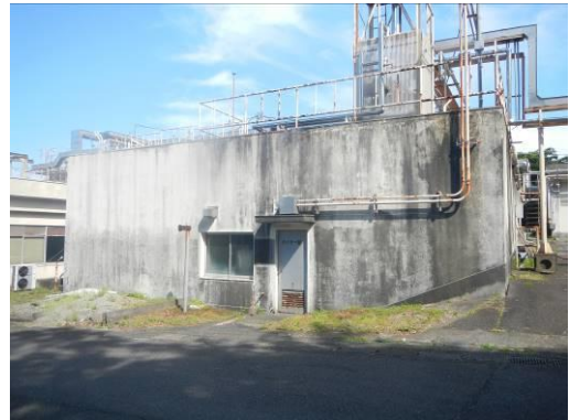
写真 3.1.4 鎌倉市深沢クリーンセンターボイラー室
