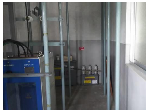
写真 4.1.6 鎌倉市深沢クリーンセンター 第 2 変電室内
