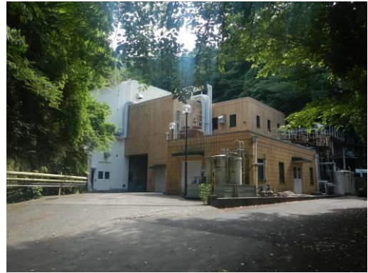
写真 3.1.2 鎌倉市深沢クリーンセンターし尿放流施設
