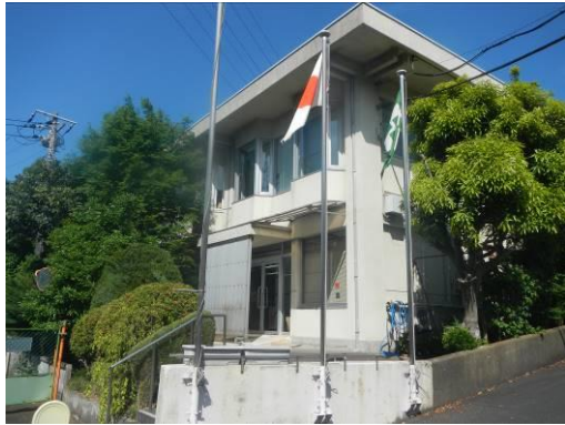
写真 3.1.1 鎌倉市深沢クリーンセンター事務所
