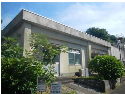
写真 4.1.5 鎌倉市深沢クリーンセンター 第 2 変電室
