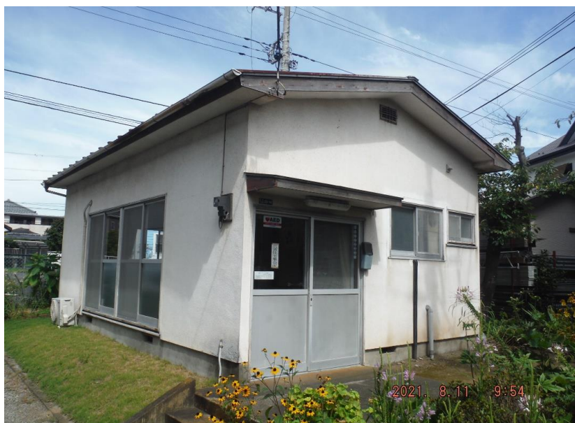
笛田住宅用地施設 集会所
