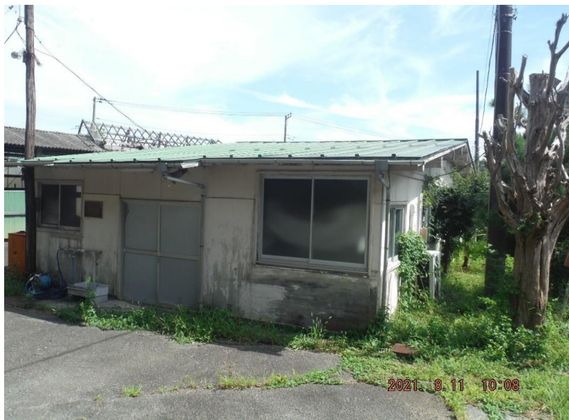
深沢クリーンセンター西側用地施設
