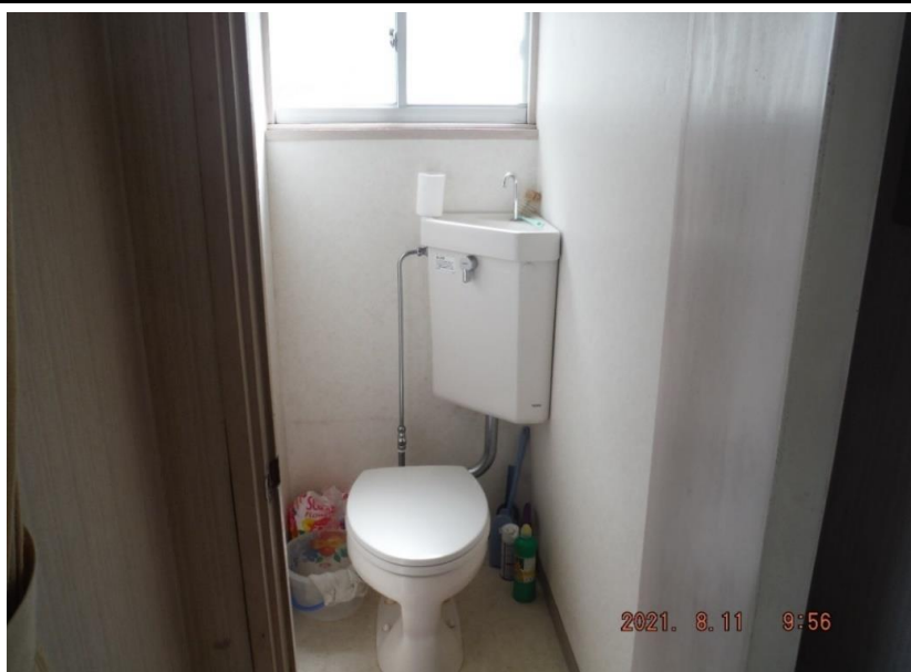
笛田住宅用地施設 集会所
