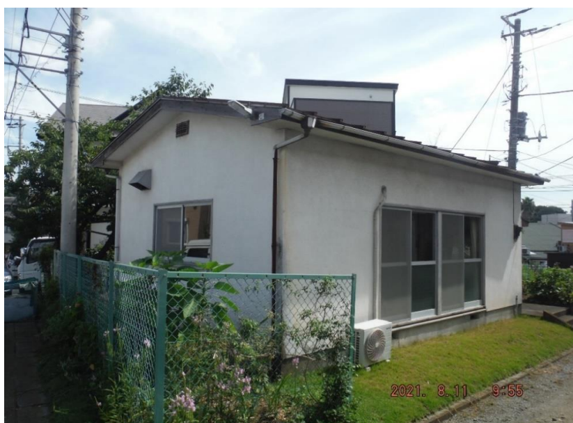
笛田住宅用地施設 集会所
