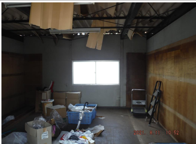
深沢クリーンセンター東側用地施設
