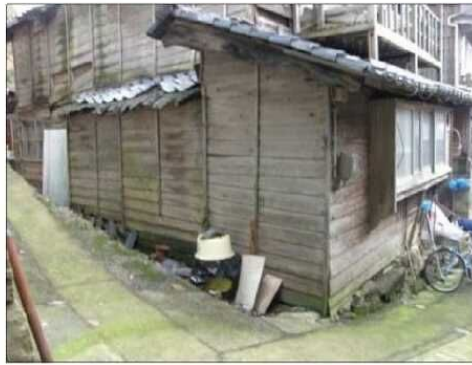
外壁が裸木造の例
